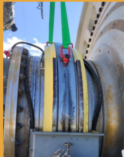
CHANGEMENT DU COUSSINET BROYEUR
